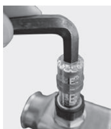
Закрыть расходомер и открутить колбу ключом
