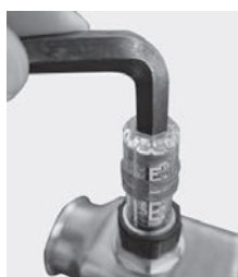
Закрыть расходомер и открутить колбу ключом
